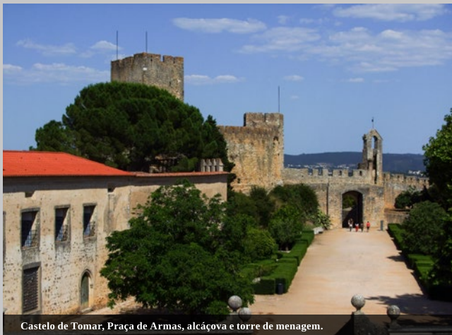
Castelo de Tomar, Praça de Armas, alcáçova e torre de menagem.
